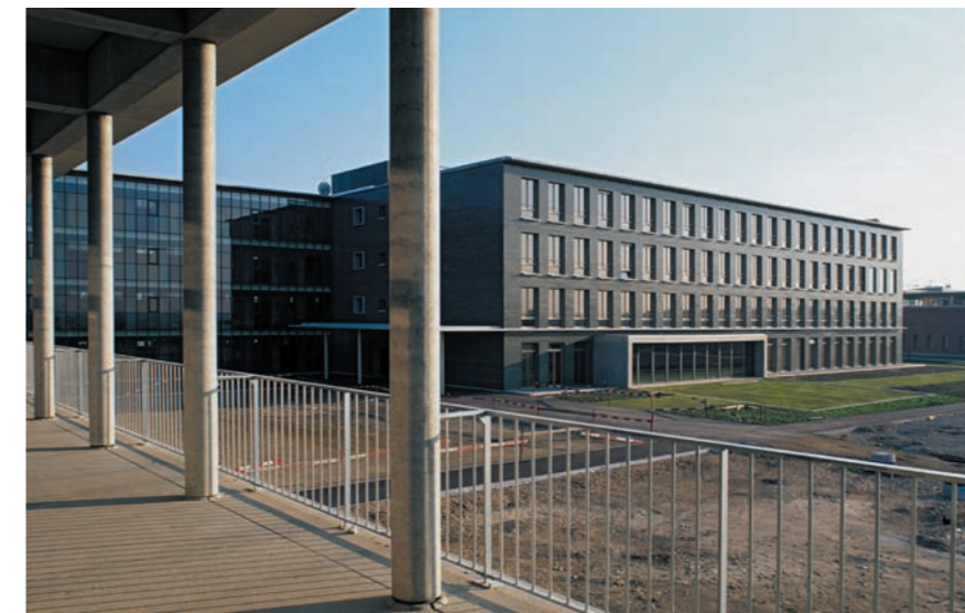
Terrasse Sepp-Glaser-Sporthalle - Ansicht Südwest
